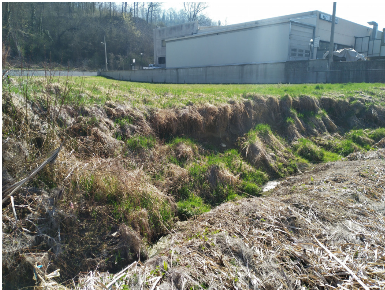
Figura 3: Il cedimento di sponda a monte del punto 4, da riprofilare e consolidare al piede con piccola scogliera in massi.
