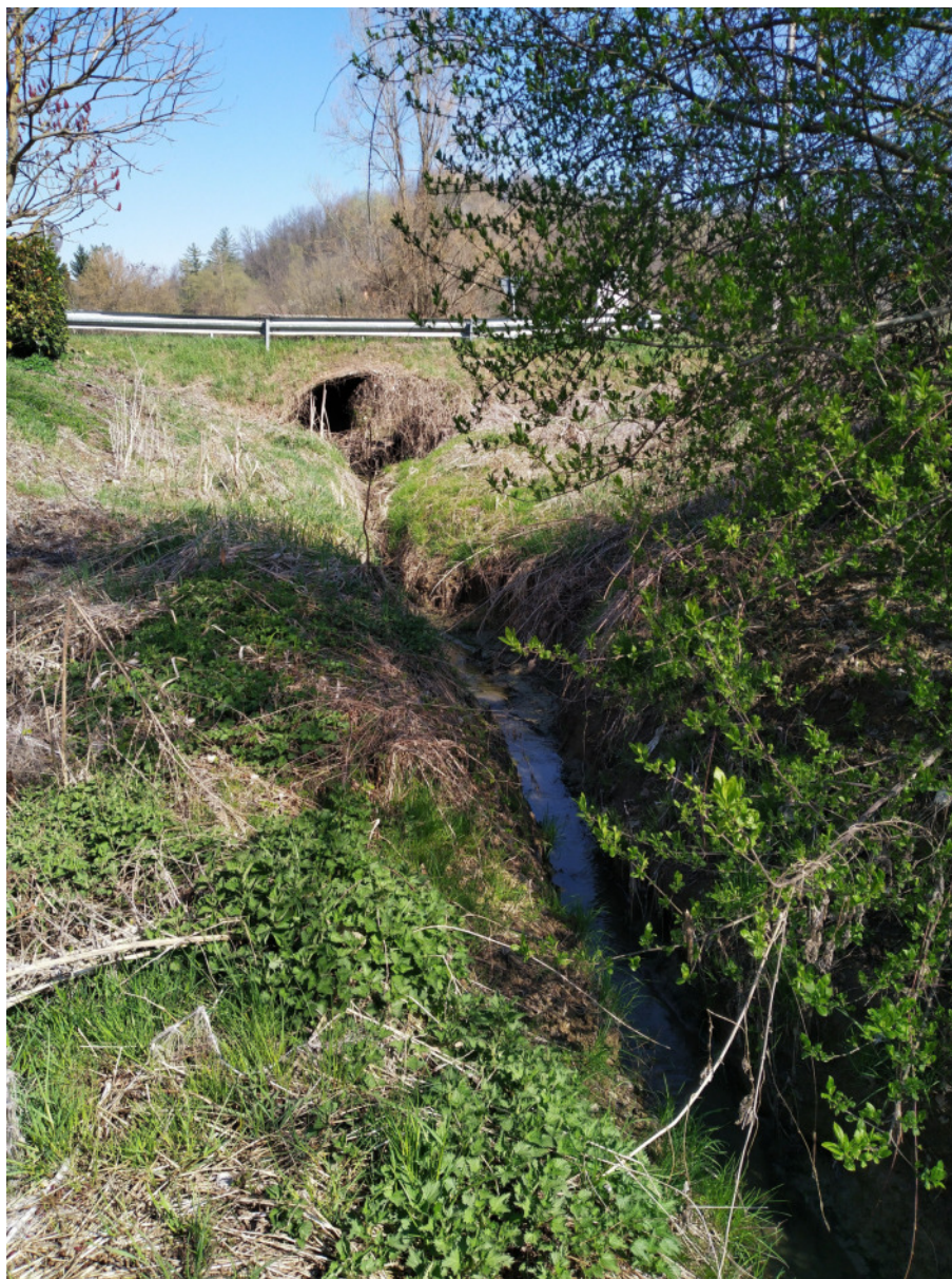
Figura 2: il tratto di rio fra i punti 3 e 5, a valle dell'attraversamento su via Calcini
