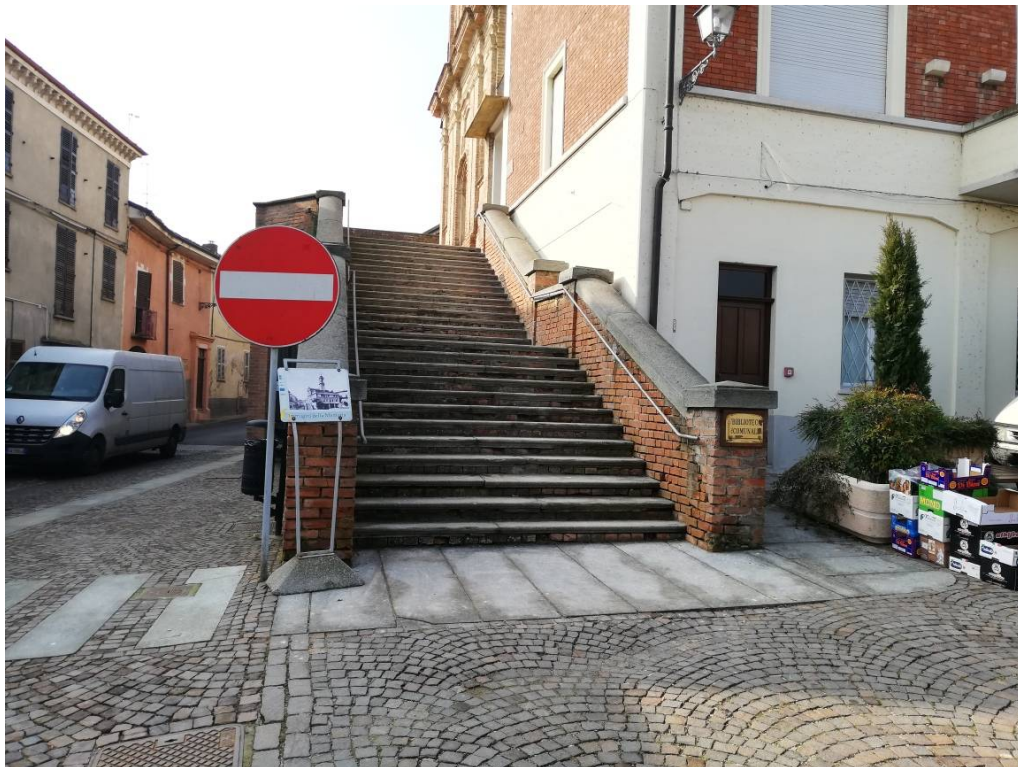
Vista frontale della scalinata
